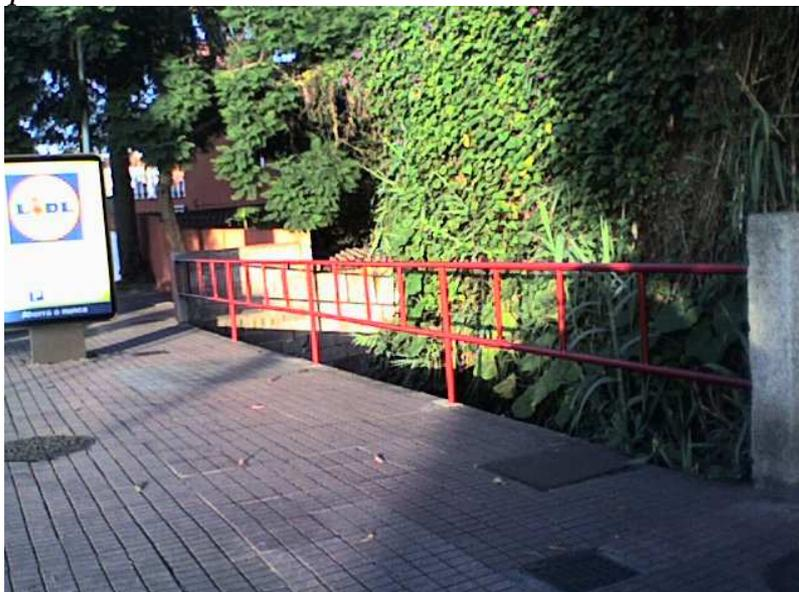
*- En la carretera Tacoronte-Tejina, a la altura del antiguo torreón de Unelco, frente al número 52-A, la acera presenta una serie de fisuras y hundimientos que, junto a la presencia de una valla y una alambrada sin fijación suficiente, suponen una situación de peligro para los usuarios de la acera, especialmente en horas*
